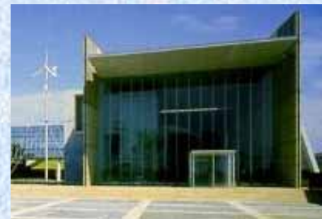
環境科学国際センター(展示館) (パンフより)
