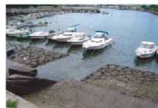
シャープの排水放流口付近 平成17年
