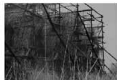
塩田の製塩方式(流下式) 昭和30年頃
