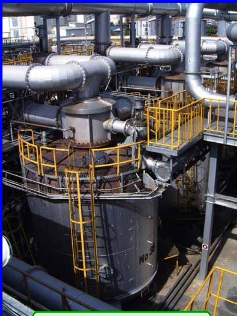
溶剤回収用吸着塔
