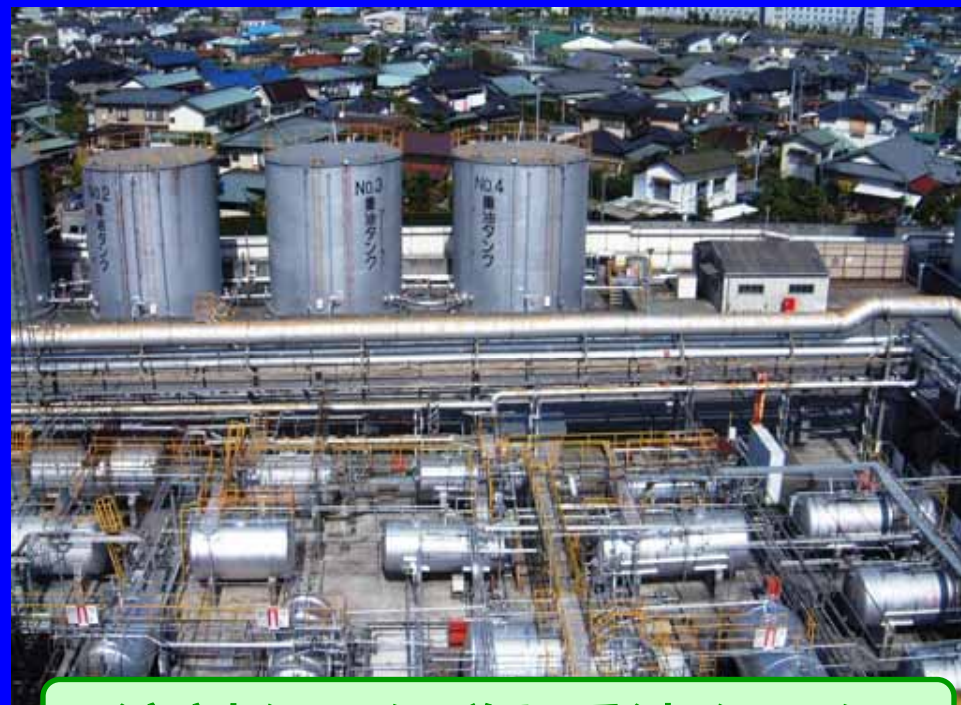
溶剤タンク群と重油タンク
