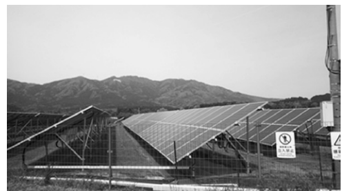
写真1 住居近くの森林が切り開かれメガソーラの設置場となった例
