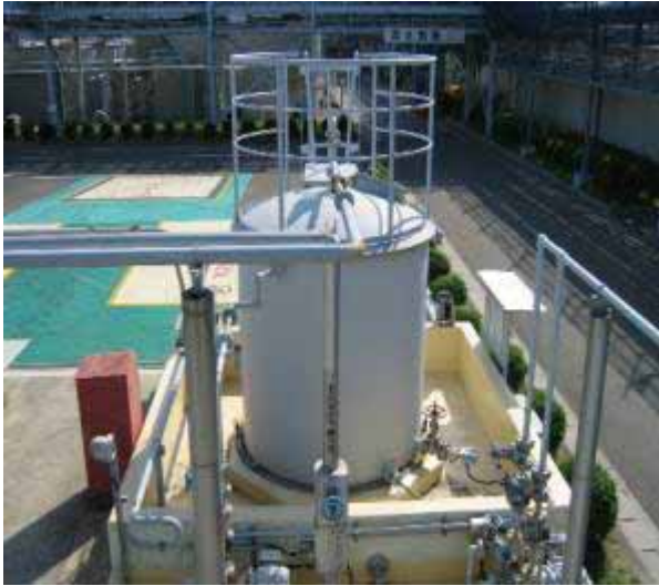
[タンク周りの防液堤]
