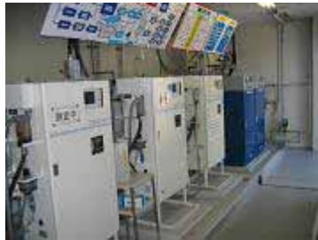
[排水自動計測器]
