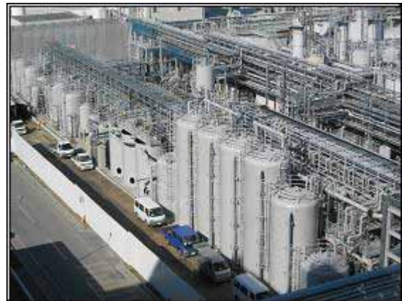
排水回収設備
