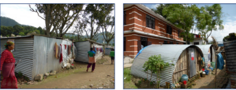
トタン建材による応急仮設住宅(NGO等からの支給)
